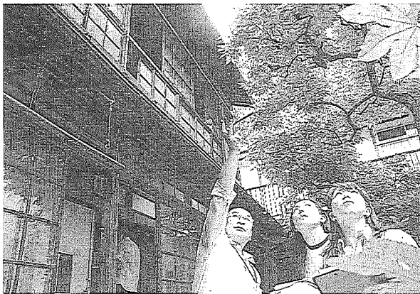
古民家鑑定士の研修。「雨どいが外れている。雨漏りの可能性があるね」とベテラン建築士が解説した＝5月、東京都豊島区雑司が谷3丁目、小山写す
